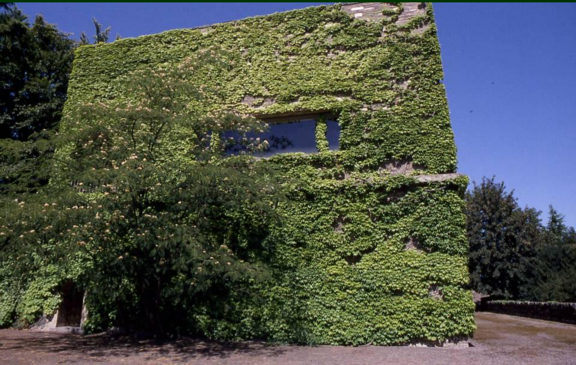
Parete verde realizzata su progetto dal paesaggista Pietro Porcinai per la cantina della Tenuta Monterosso ad Acqui Terme (AI)
